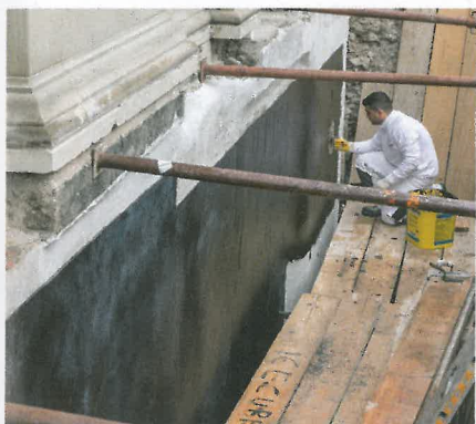
Dringt seitlich Feuchtigkeit in das Mauerwerk, ist eine Außenabdichtung ratsam. Foto: Isotec
