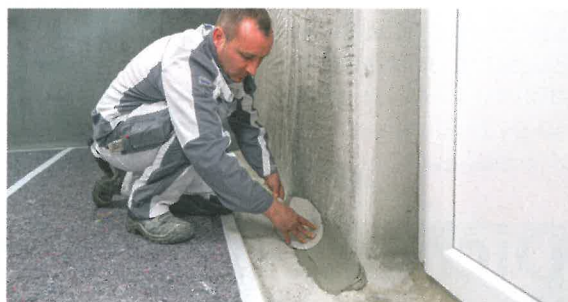
Das Flexband dichtet Risse in Beton ab und schützt dort vor Feuchtigkeit. Foto: Isotec
